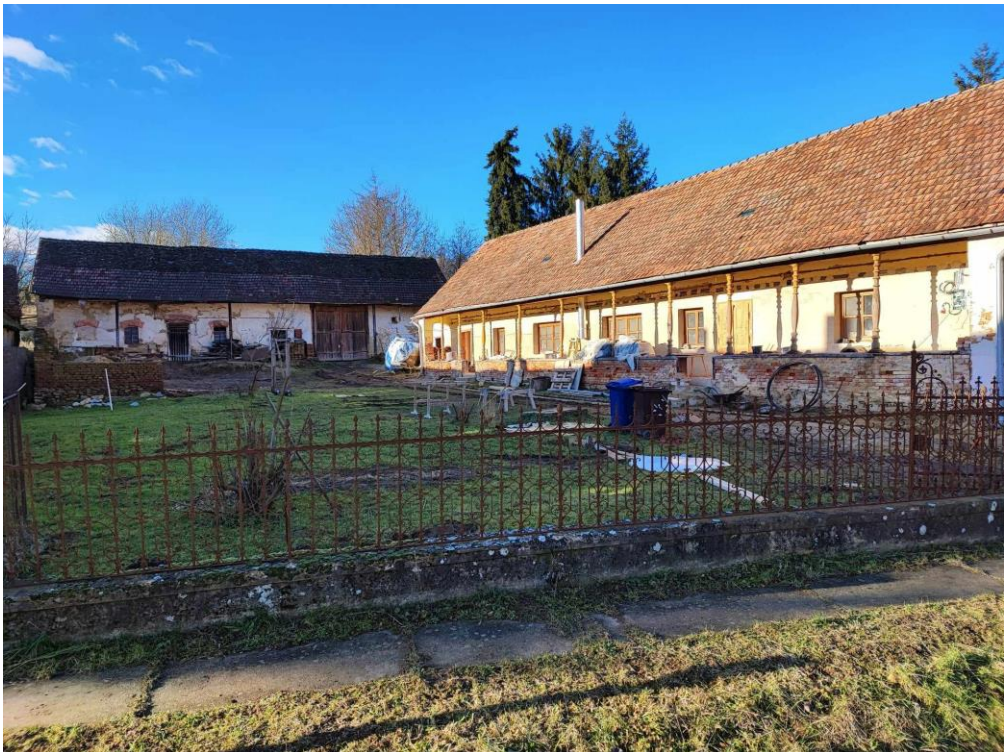
3. kép: Leromlott állapotú lakóház csúrral Tótfűn. Picture 3: Dilapidated home with barn in Tótfű.
