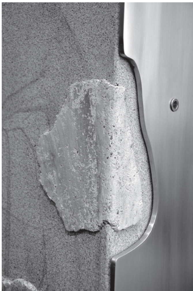
2. kép. Festett oldalfalú átjáró a beillesztett eredeti freskótöredékekkel. Belső sarok. Rekonstrukció: Harsányi Eszter – Kurovszky Zsófia. Fotó: Hódi Attila
