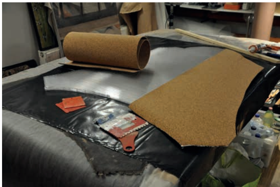
16. kép. Panel készítése a felső képek számára: a formára vágott polikarbonát lemezre parafa elválasztó réteg kerül semleges szilikongumi ragasztóval
