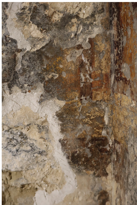
18. kép. A megégett, kérges felület feltárás közben Fig. 18. The burnt, crusty surface during removal
