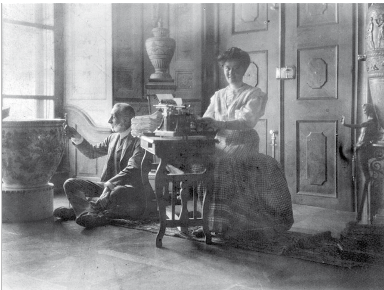
Radisics Jenő munka közben 16
