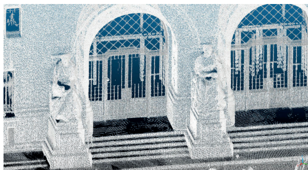
3. ábra A BME Központi épületének homlokzatáról készült TLS-felvétel – részleges takarásokkal, egyenletlen ponteloszlással és hiányos visszaverődésekkel
