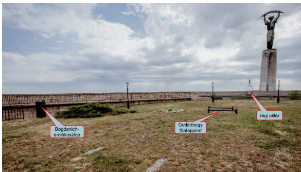
1. ábra A Citadella felújítása előtti állapot, 2020
