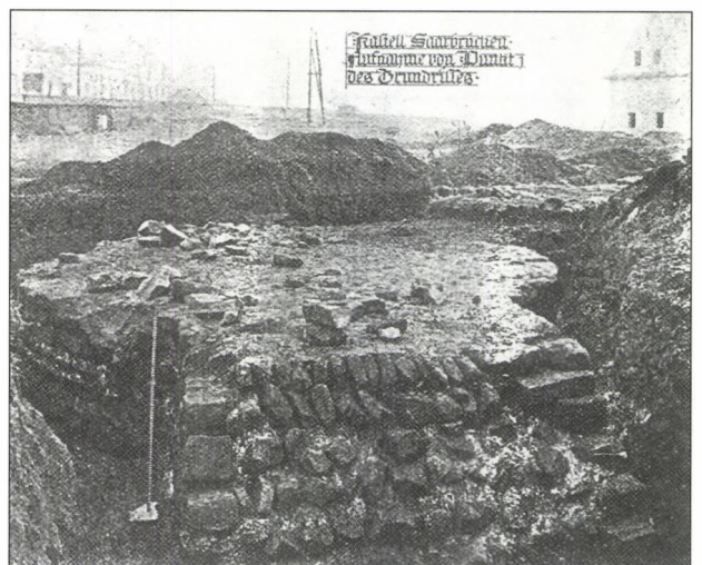
Abb. 19 In eine Mauerflucht eingebundener, mittels Schüttbauweise vollständig ausgefüllter runder Turm der valentinianischen Festung in Saarbrücken
