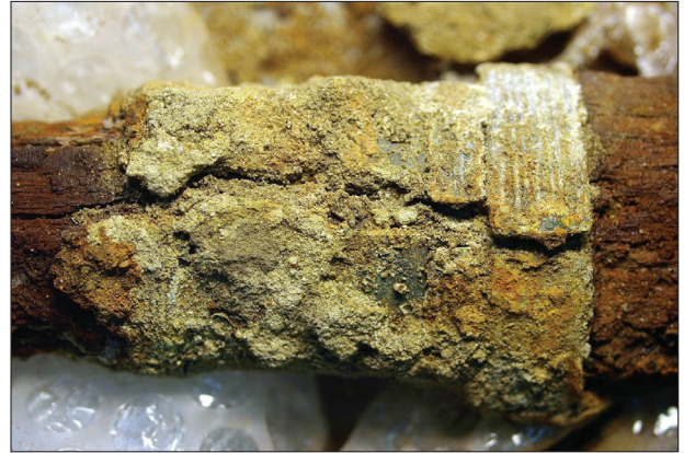
3. kép Korróziós termékek halmaza és a korrózió által eltávolodott illesztések Fig. 3 Rust and once attaching surfaces separated by corrosion
