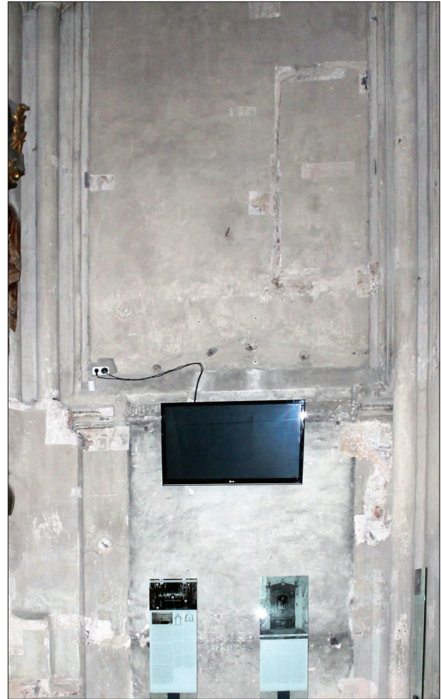
4. kép A déli mellékhajó vége az elfalazott ajtó kontúrjával (fotó: Takács Ágoston)
