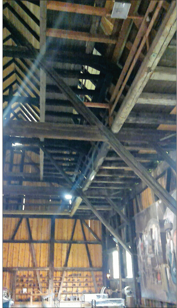
9. kép Az üvegcsűr feltételezett tetőszerkezete egy németországi példa alapján (fotó: Borsi-Lakatos László)
