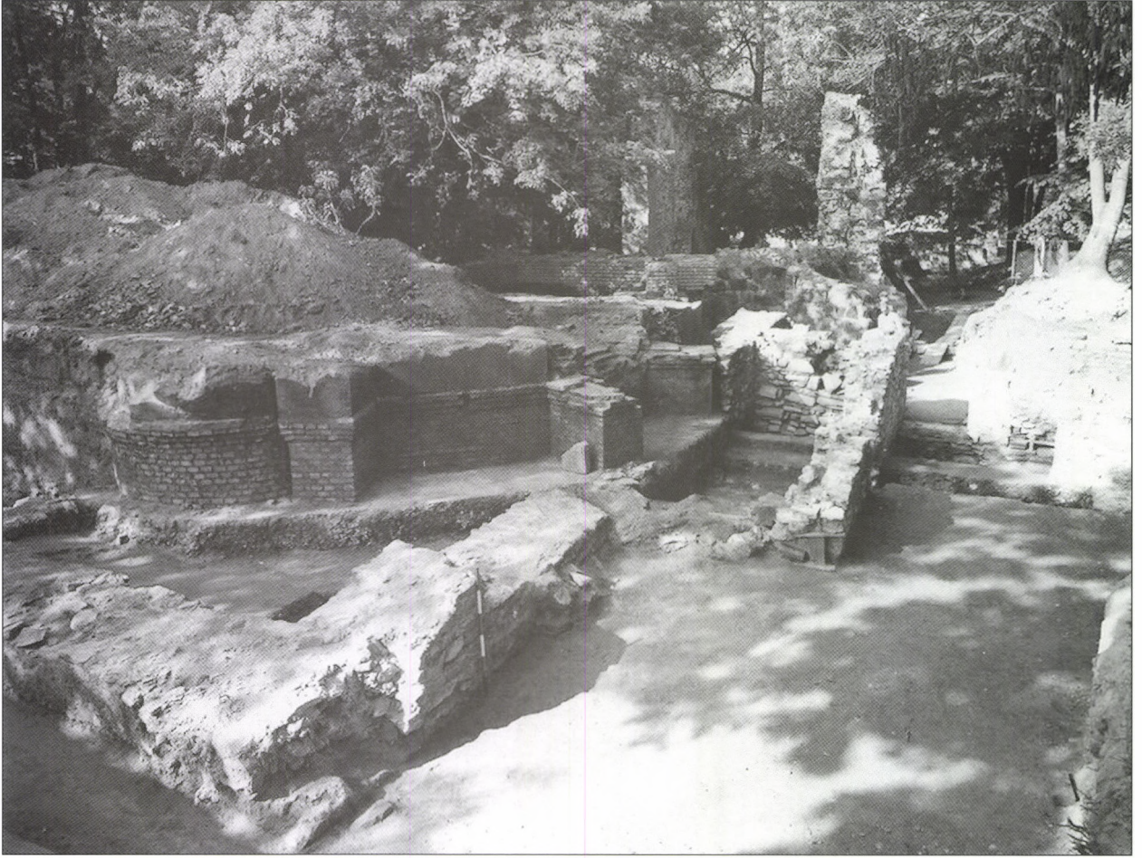
5. kép Budapest XIII. Margitsziget, romkert. A kastély D-i épülete: az É-i és a K-i fal feltárás közben. 13–16. század Abb. 5 Budapest XIII. Bezirk. Margareteninsel, Ruinengarten. S-Gebäude des Schlosses: N- und O-Wand während der Freilegung. 13.–16. Jh.
