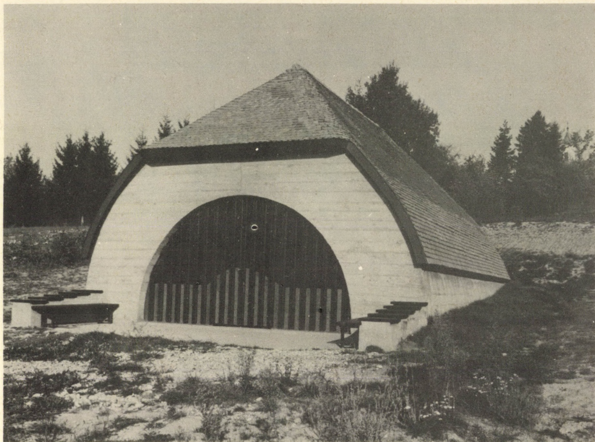
21. kép. Az őriszentpéter téglaegető védőépülete. Abb. 21. Der Schutzbau des Ziegelofens von Óriszentpéter
